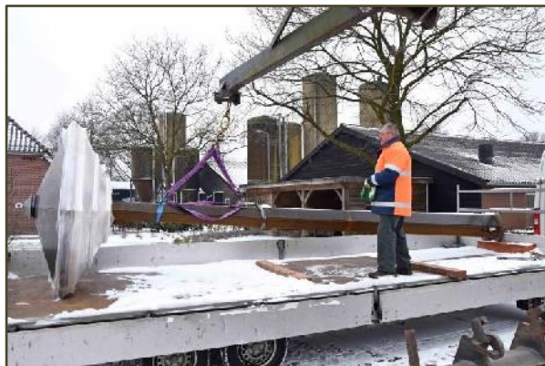
De huiszwaluwtil aan de Lage Burchtweg in Uden. 📷 Martien van Dooren
