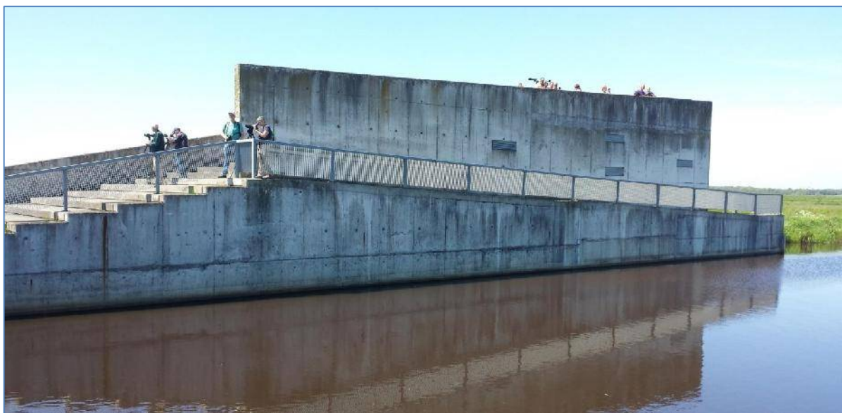
Bovenop het gemaal heb je een prachtig uitzicht over het gebied
