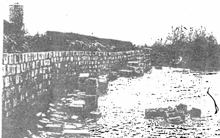
De oeverwaluwanwand bij 'Het Hemelrijk' in aanbouw, februari 1986.
